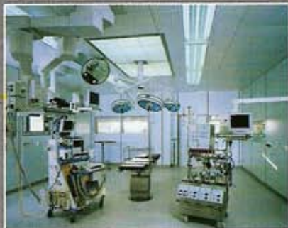
Pose de plafond laminaire
