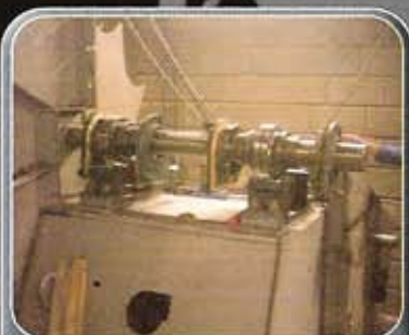
Maintenance Industrielle Remplacement roulement à bain d'huile
