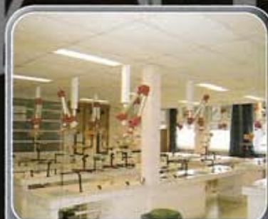
Fluides Installation réseau Air / Eau
