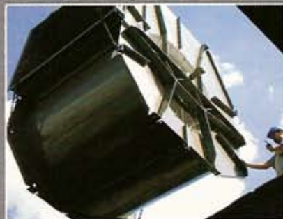
Remplacement de ventilateur industriel
